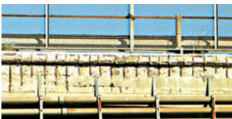
CASTEL ROMANO Ponte con armatura a vista
