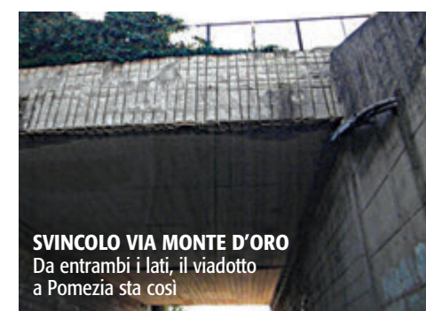
148, VERSO SUD Cemento fradicio e armatura pericolante al Km 32,8
