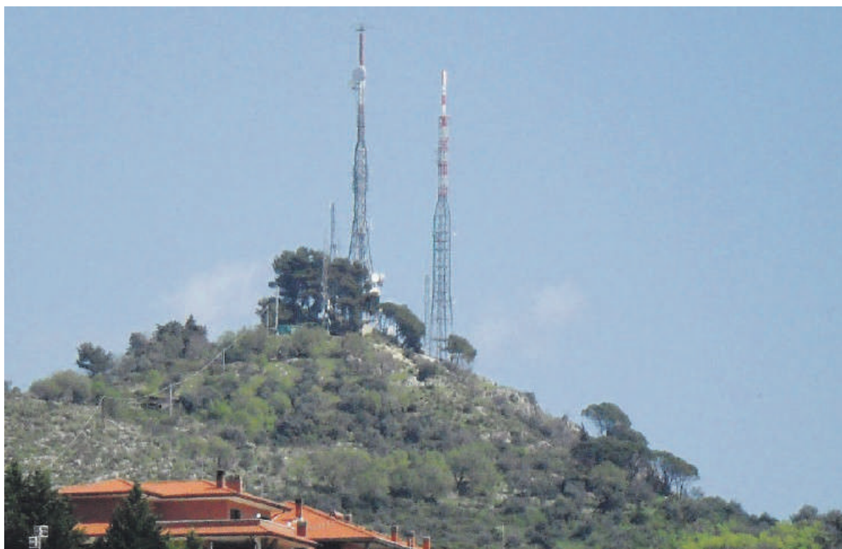
Le antenne installate sul Monte Trevi
