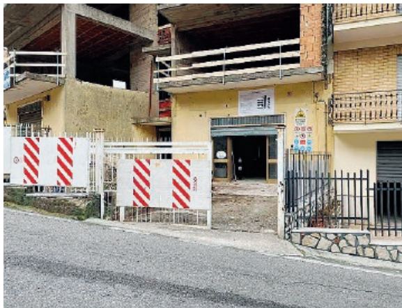
I lavori di riqualificazione degli alloggi Ater in via San Gaspare
