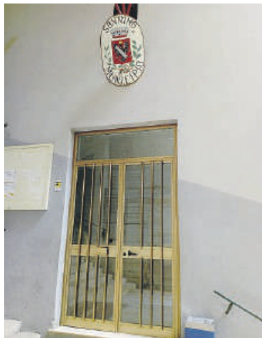
L'ingresso del Comune
